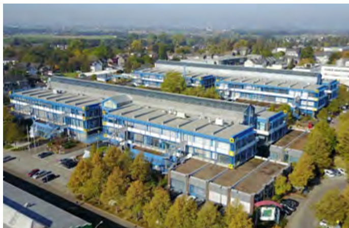
■ Das veraltete Gebäude im Technologiepark Herzogenrath TPH II
